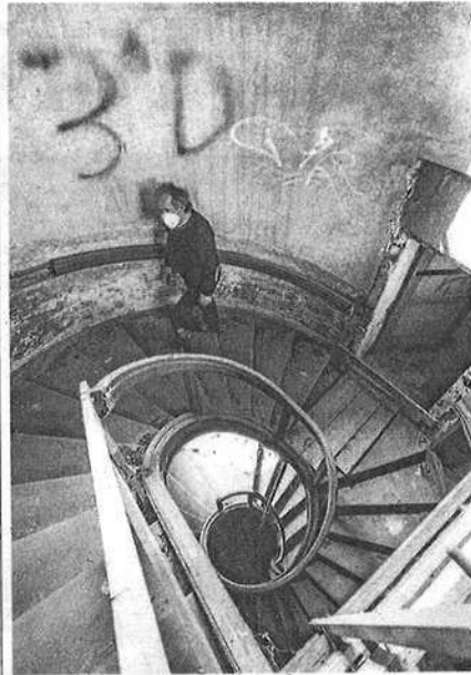
© Grugliasco Nelle fotografie di Tino Romano l'esterno e gli interni di Villa Il Maggiordomo nell'area del Gerbido, tra Torino e Grugliasco. A sinistra, l'architetto Antonello Sado sulla scala elicoidale di Carlo Ceppi Sotto, i ponteggi e le coperture imposte dalla soprintendenza per evitare ulteriori crolli. Alla costruzione della villa hanno messo mano Guarino Guarini e Baroncelli
