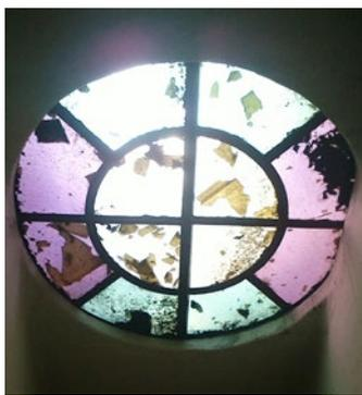
Presso la **Scuola secondaria di primo grado "Gramsci - Europa Unita"**, sono stati forati in gran parte della superficie i lucernari in materiale plastico posti nella parte centrale del solaio di copertura della palestra. La palestra è inagibile a tempo indeterminato e, per evitare danni alla pavimentazione sottostante, sono stati posizionati provvisoriamente del Comune e della ditta Dimensione S.p.A dei grossi te-
