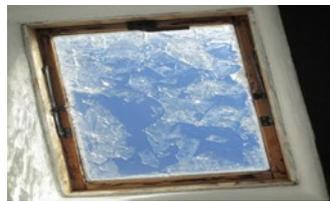
**Cappella di San Grato di via La Salle/via Perotti**, gran parte dei vetri esposti a nord e ad ovest risultano rotti e necessitano di sostituzione. È stato eseguito un intervento per il transennamento del marciapiede sottostante e l'eliminazione delle vetrate
