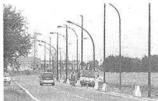
Il cantiere della pista ciclabile
