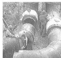
La posa delle tubazioni
